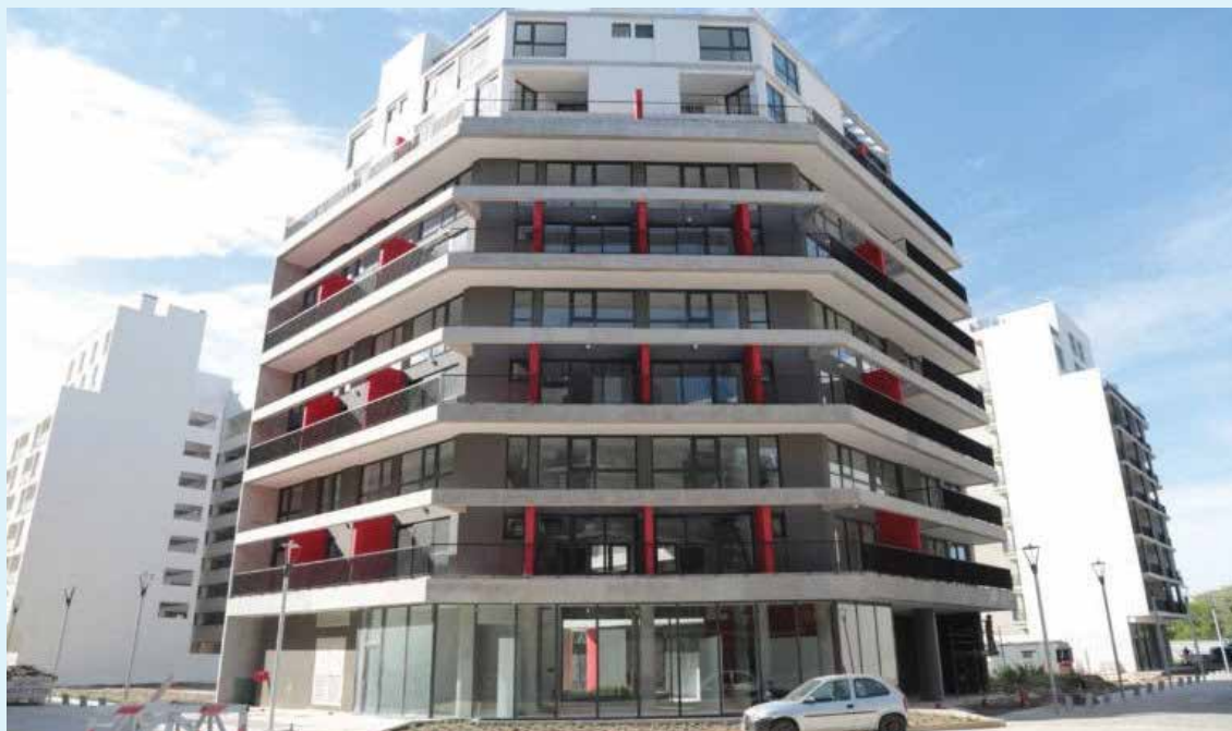
Edificio de la Villa Olímpica en la Ciudad de Buenos Aires.
