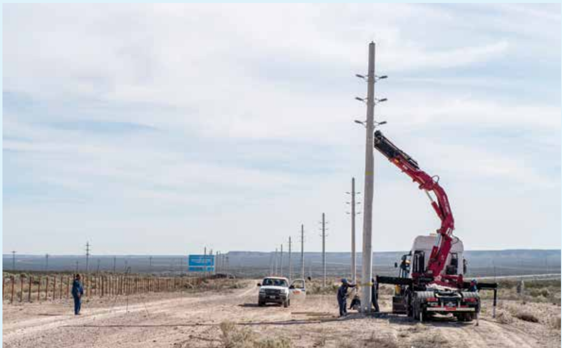
Nuevo tendido eléctrico con tecnología de punta en la provincia de Río Negro.
