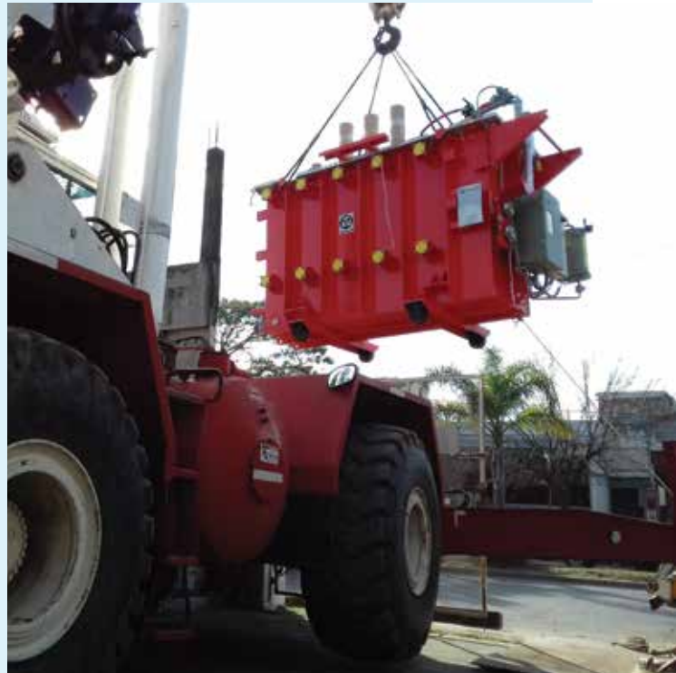
Instalación de los nuevos transformadores en la capital de Corrientes.
