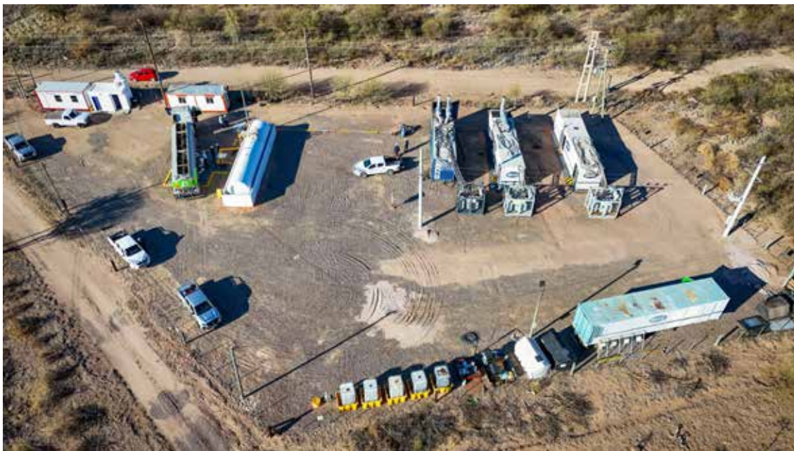
Vista panorámica de la obra.
