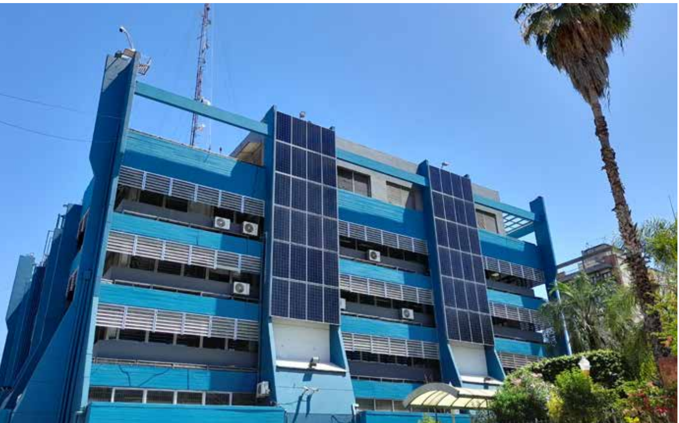
Edet genera con paneles fotovoltaicos parte de la energía que consumen sus edificios.
