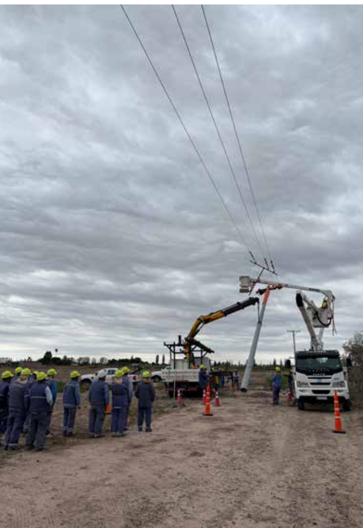
Colaboradores durante el "Reciclaje del departamento de trabajos con tensión (TCT) a contacto y a distancia".
