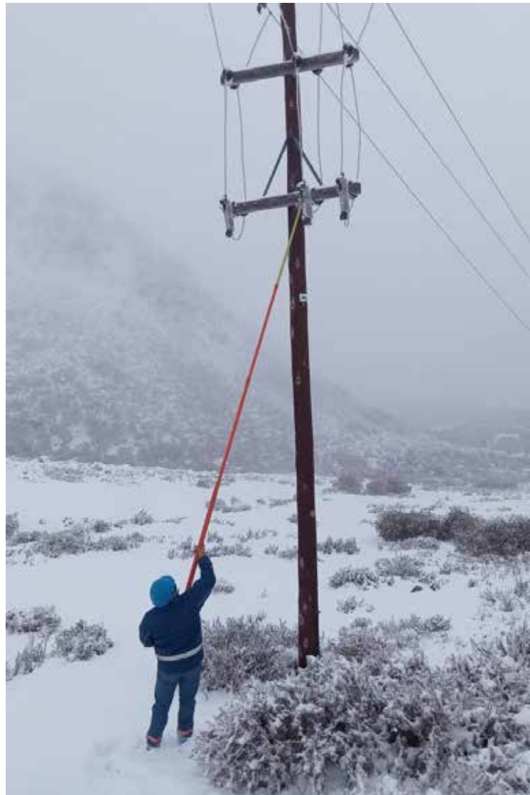
Los postes de media tensión obsoletos o dañados por inclemencias climáticas comienzan a ser reemplazados por otros de PRFV.
