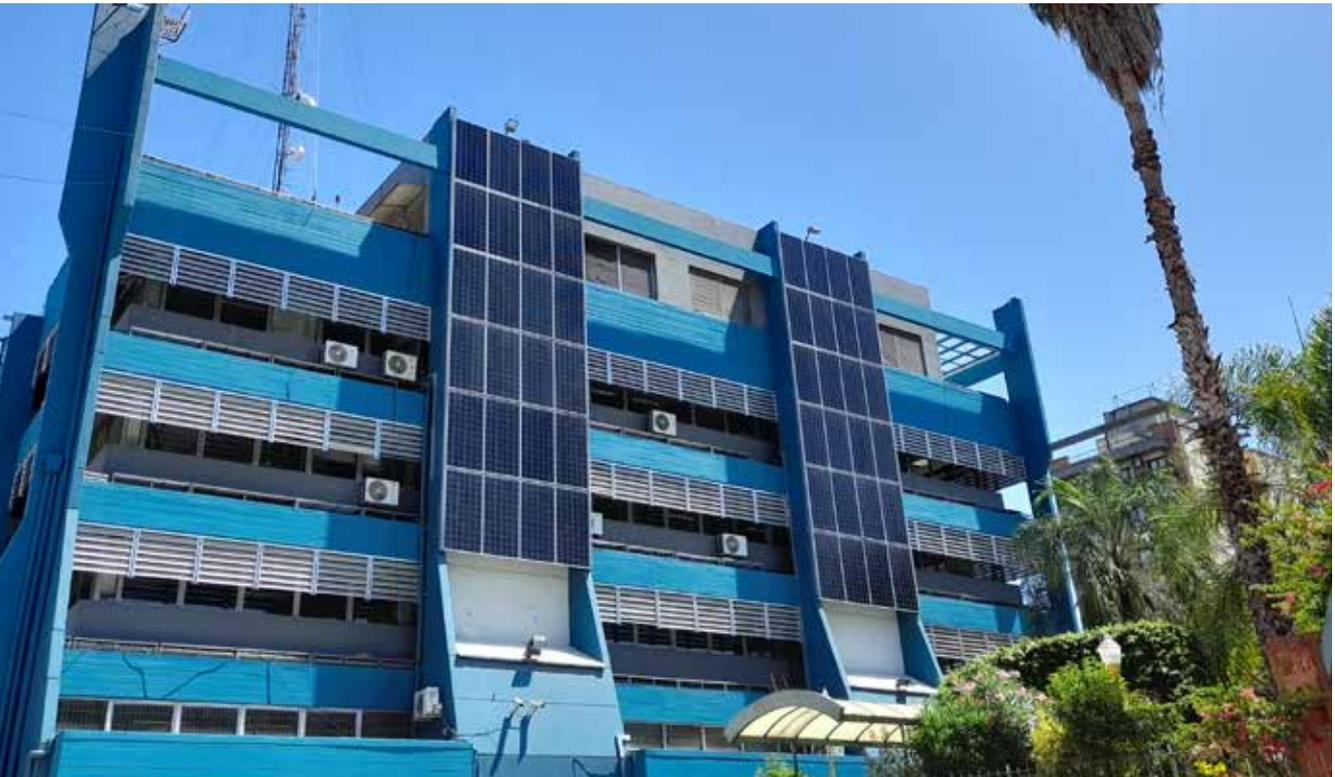
*Edet genera con paneles fotovoltaicos parte de la energía que consumen sus edificios.*
