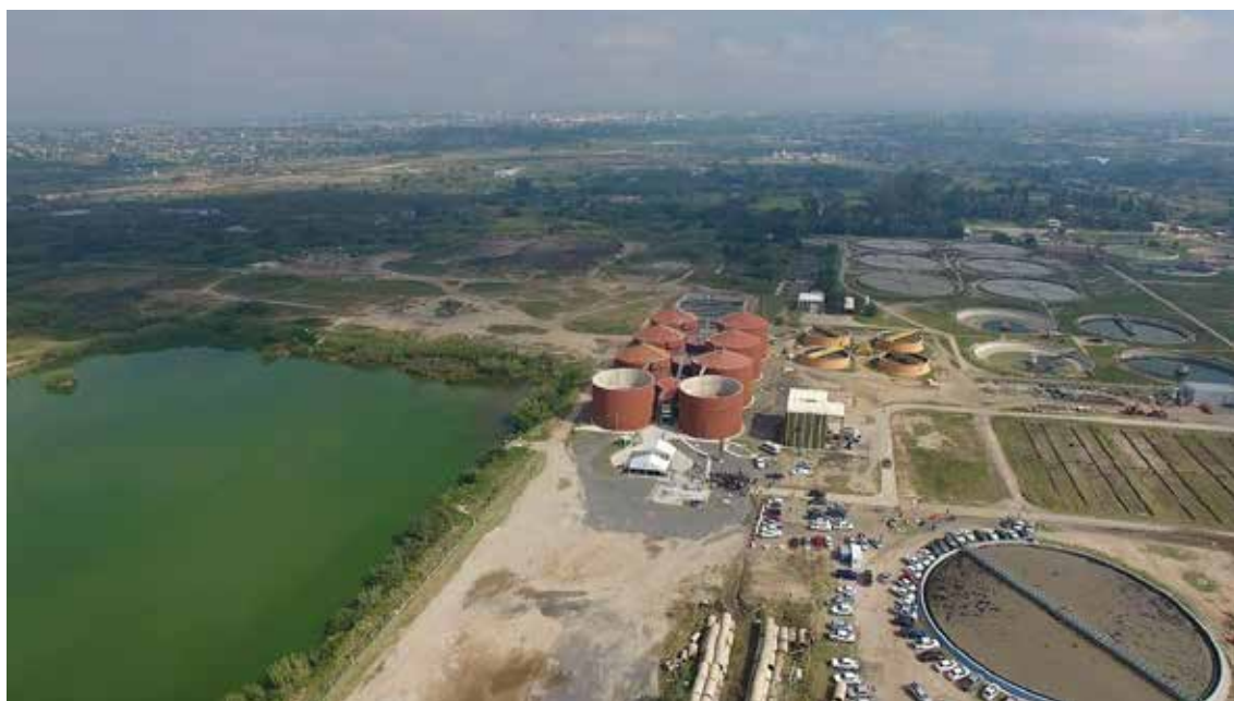
Planta de tratamiento de líquidos cloacales Bajo Grande.
