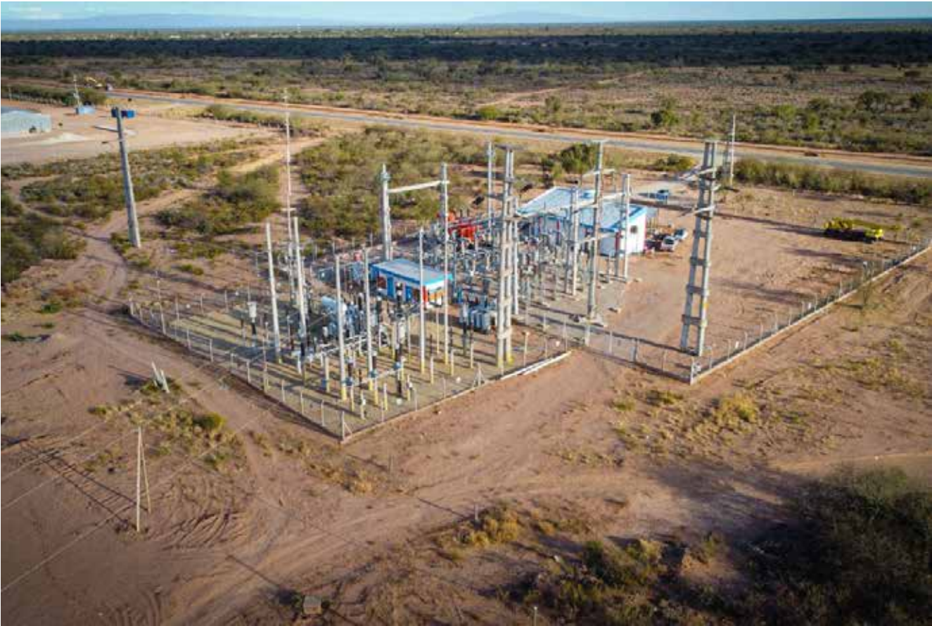
Obras en La Rioja.
