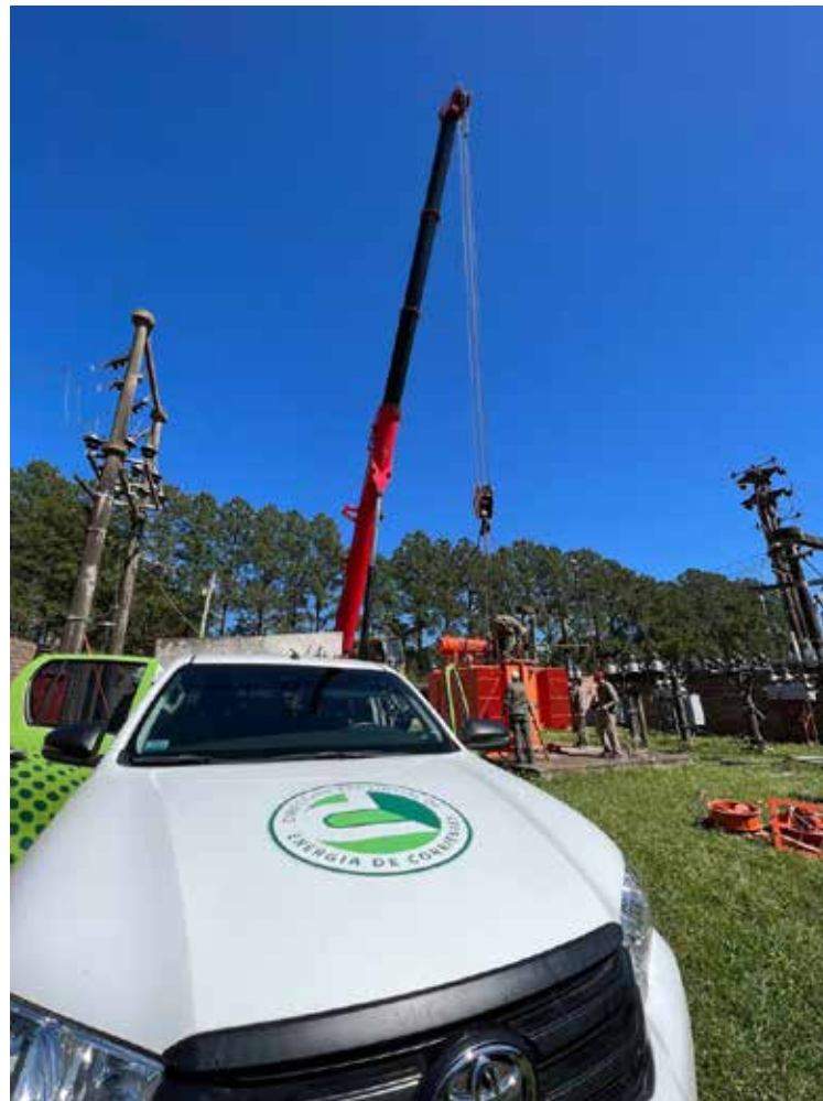
Trabajos en la estación transformadora "Golf Club".
