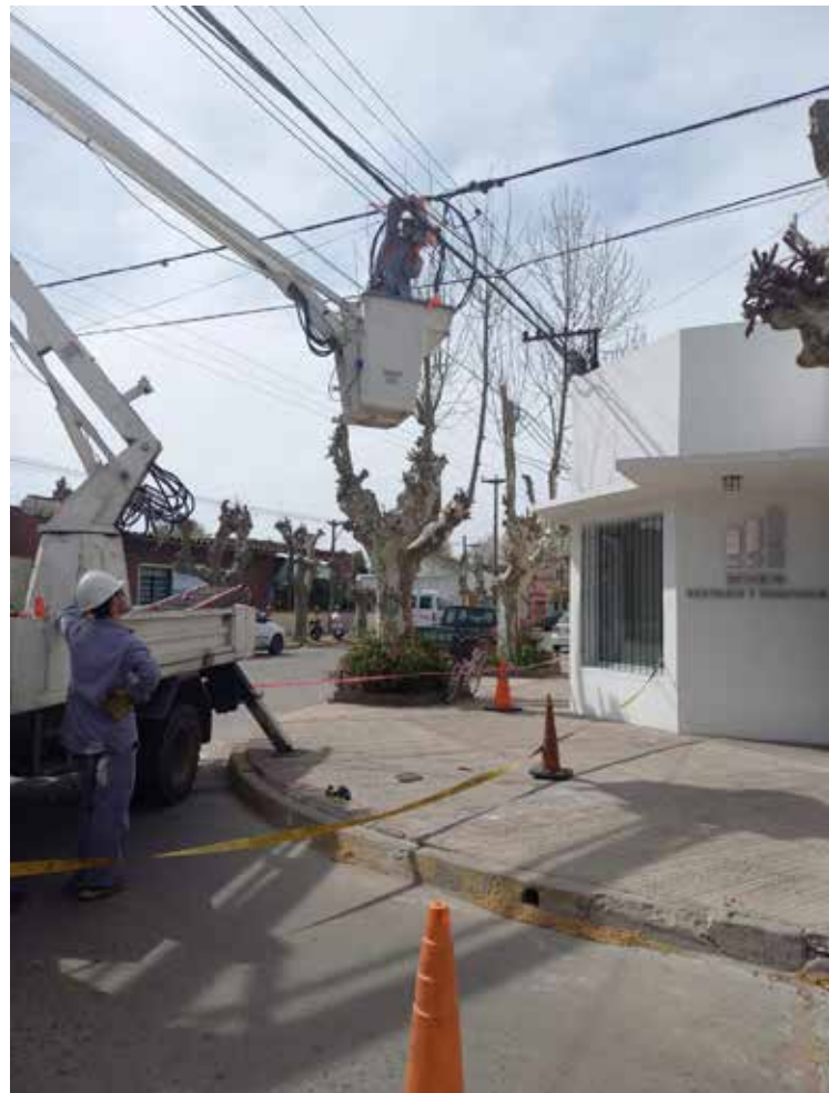
Obras en la localidad de 25 de Mayo.
