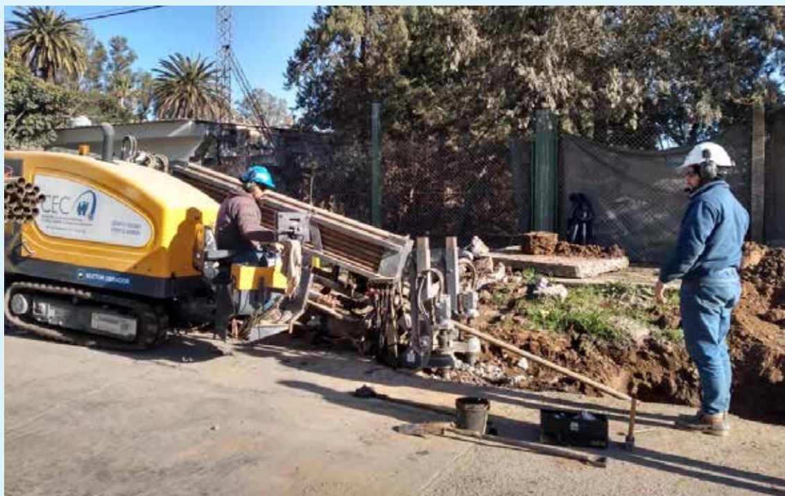
La Tunelera Direccional posibilita minimizar los inconvenientes que una obra de este tipo genera ya que optimiza tiempos y recursos.
