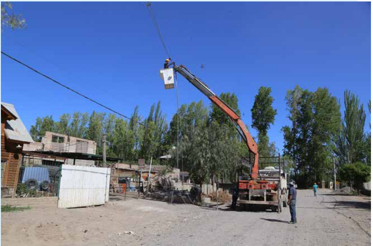
Se concretaron trabajos en más de 30 asentamientos y se benefició a alrededor de 3.200 familias.
