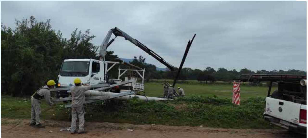
Montaje de columnas Distribuidor PQ22 Aguaray.
