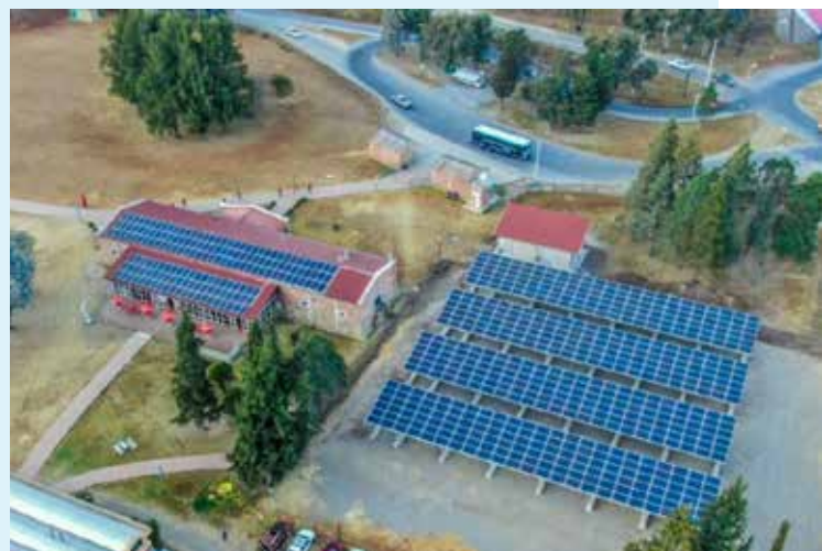
Estacionamiento Solar en Universidad Católica de Salta conectado a la Red mediante Balance neto.
