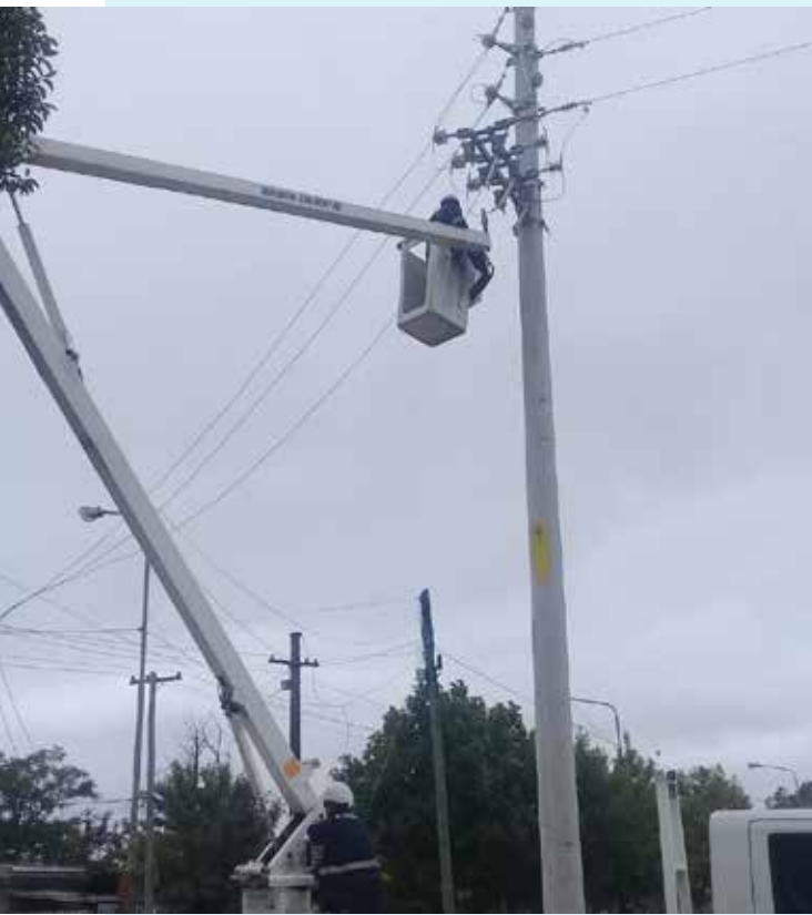
Ejecución de obras de expansión y renovación a lo largo de 198,2 kilómetros de red de baja y media tensión.
