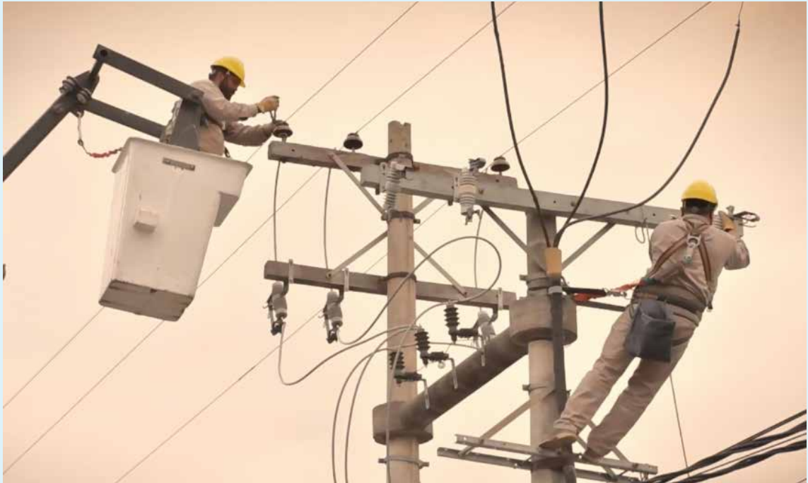
Renovación del distribuidor ferroviario en 13,2 kV.
