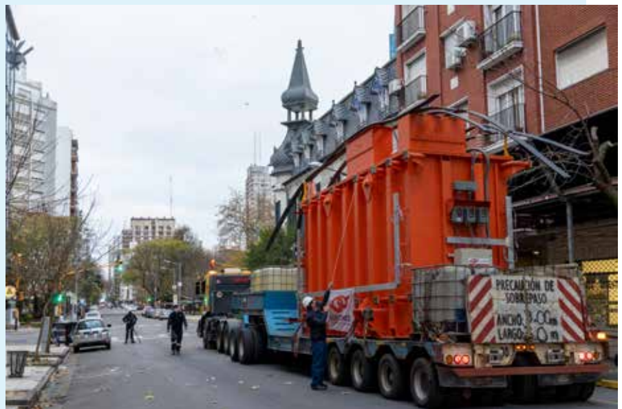
La obra comprende el reemplazo de uno de los dos transformadores de 44 MVA por otro de 55 MVA y la instalación de nuevos equipos de telecomando y medición.
