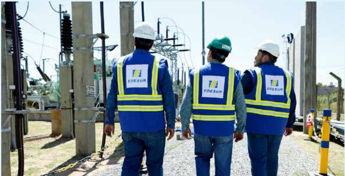
Supervisión de una de las obras de Edesur.
