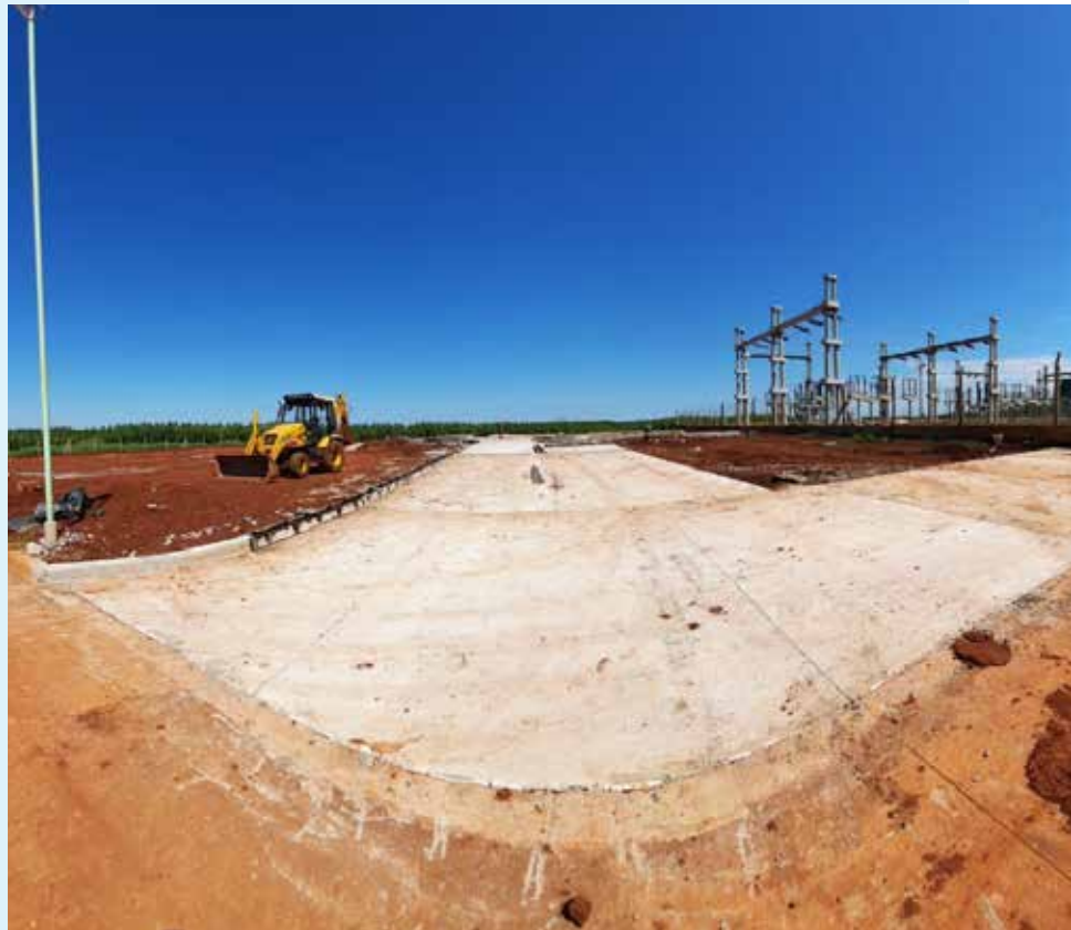
Construcción de la ET 132/33/13,2 kV San Alonso en la localidad de Virasoro.
