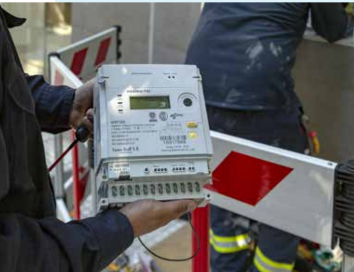
Instalación de medidor inteligente a un cliente de grandes demandas.
