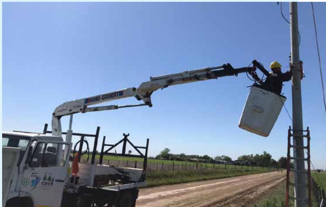
Trabajos de la Cooperativa Eléctrica en la ciudad de Colón.
