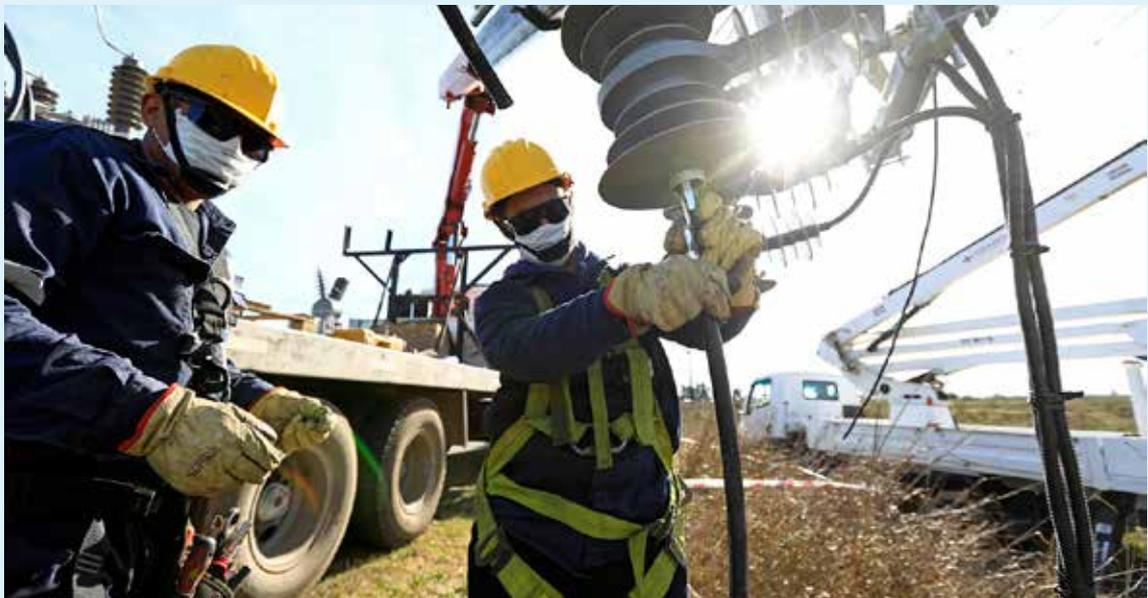
Los operarios realizaron poda, despeje de alimentadores, cambios de cableado, reemplazo de aisladores e instalación de nuevos telemandos.
