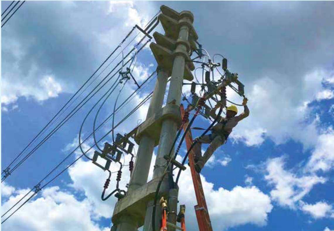
Se realizaron obras para proveer energía al Centro Distribuidor Zorrilla.
