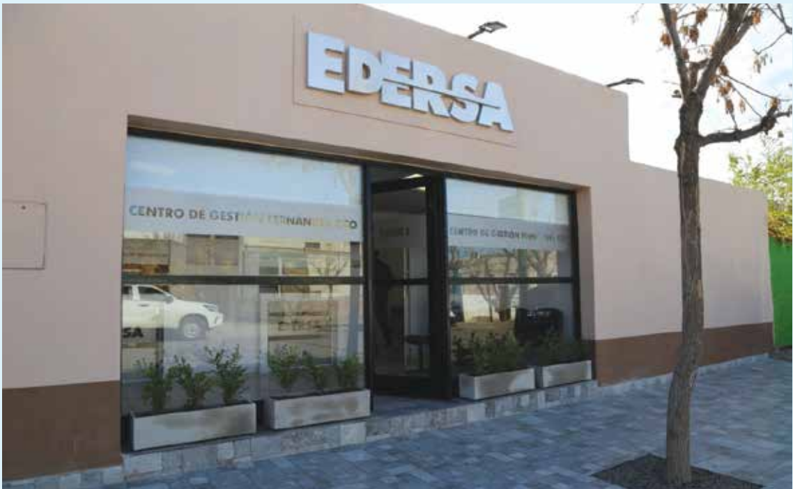
EdERSA construyó y remodeló nuevos edificios comerciales.
