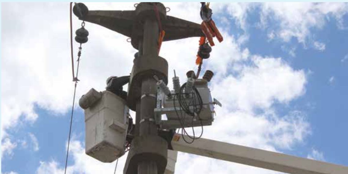
Edesur realiza grandes obras de infraestructura en redes de Alta, Media y Baja Tensión.
