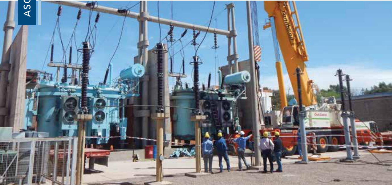
Montaje de la Estación Transformadora Las Heras.
