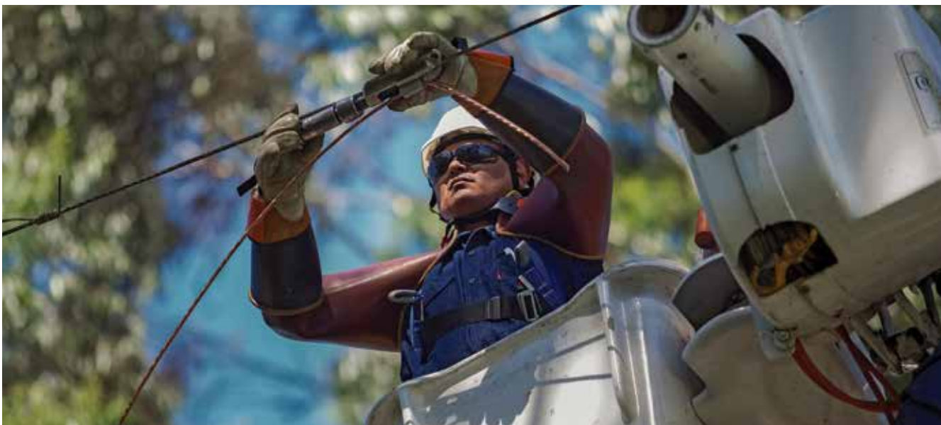
Operario de EDET- Trabajo en Tensión.
