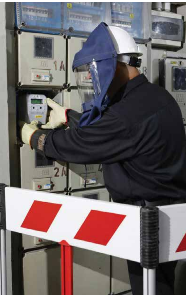
Instalación de los primeros Smart Meters en Caballito.
