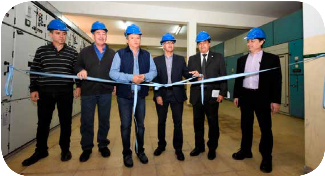
Inauguración de las nuevas celdas de media tensión.
