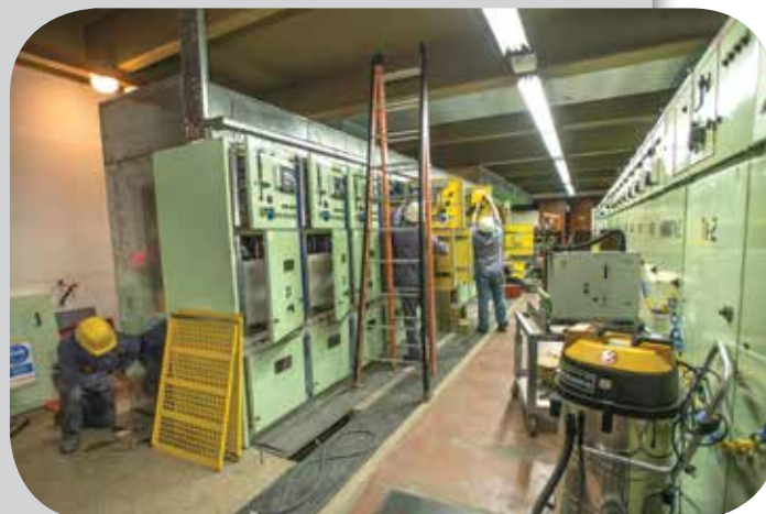
Operarios trabajando en la Subestación Caballito.
