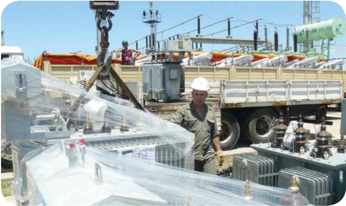
Profesionales de la DPEC trabajando en la instalación de transformadores.
