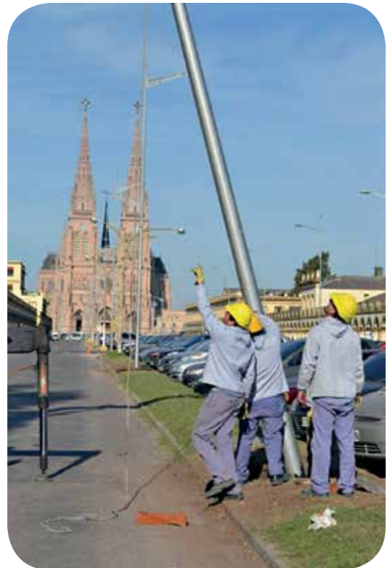
Personal de la CESPLL realizando trabajos de instalación de columnas.
