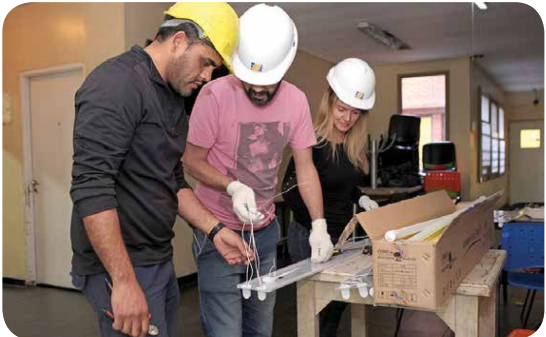
Trabajadores de EDESUR instalando luminarias LED.
