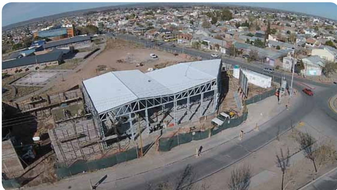
Vista aérea de la nueva ET Argentina al 30% del avance de obra.
