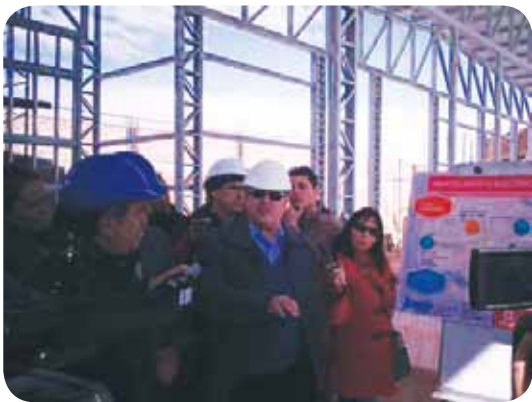
El Ministro de Energía de la provincia, Ing Alejandro Nicola, supervisó la obra.
