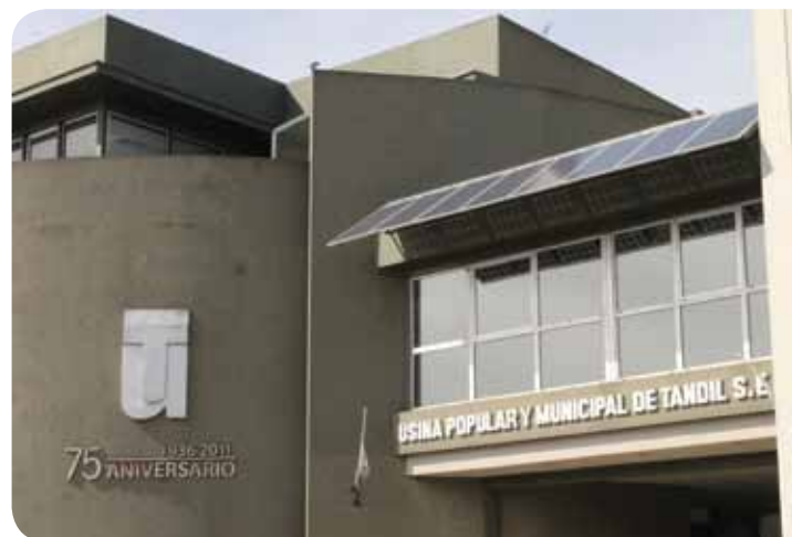
El edificio de la Usina forma parte de uno de los cinco lugares donde se instalarán los equipos
