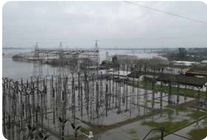
ET de Campana afectada por el fuerte caudal de agua que azotó a la provincia
