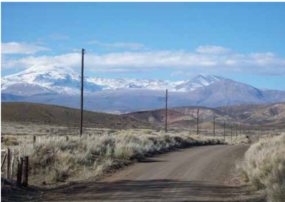
Montaje de estructuras 13,2 kV del paraje Rahueco, en el norte neuquino.
