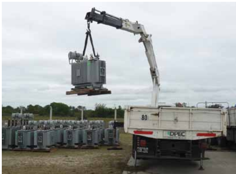
Llegada de los nuevos transformadores trifásicos de 315 KVA.
