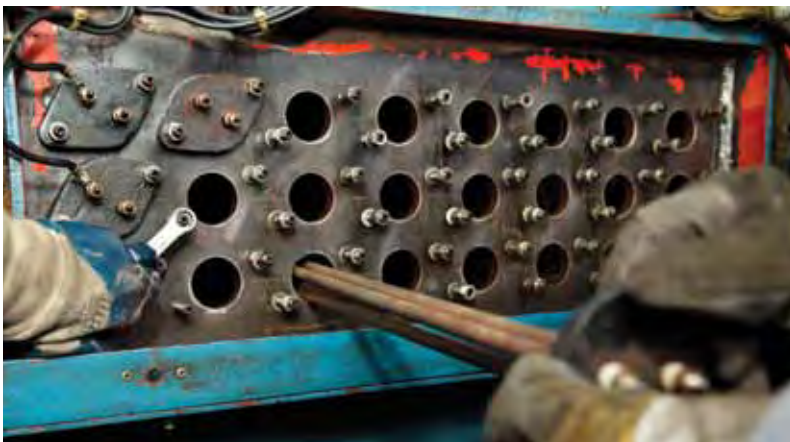
La reparación de la maquinaria se hizo integralmente con personal propio.
