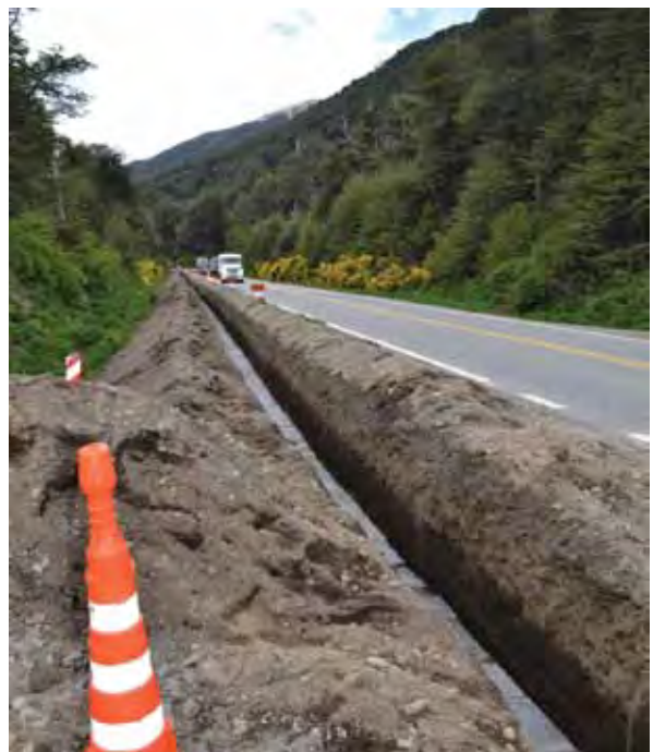
Las obras de tendido de cables al costado de la ruta 40.
