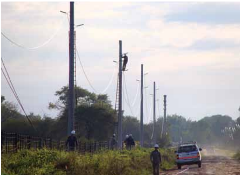
Operarios de SECHEEP realizan obras de tendido eléctrico en Margarita Belén.
