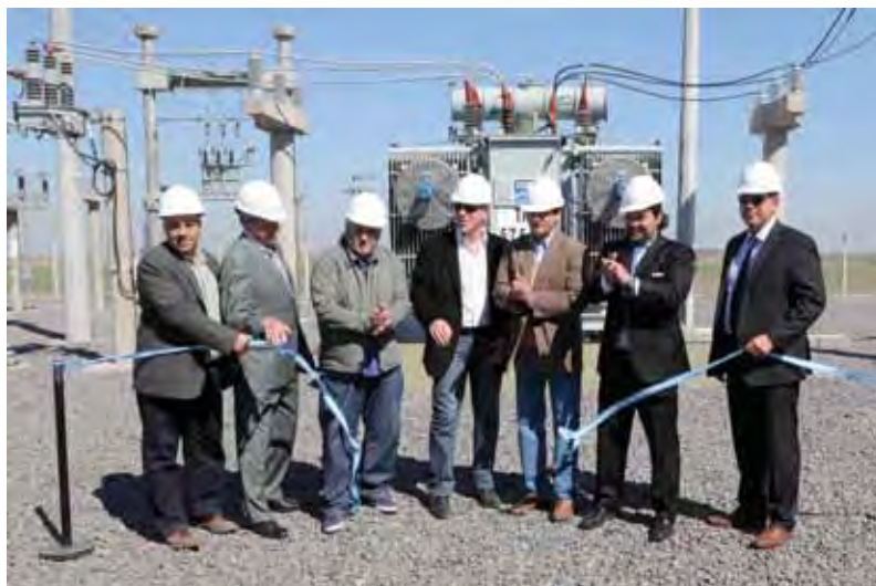
Corte de cinta en la inauguración de la Estación Transformadora Roque Pérez II.
