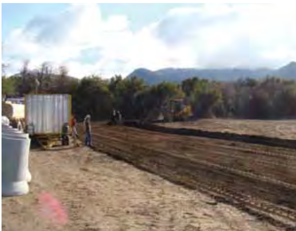
Nivelación del terreno en Paso Coihue.
