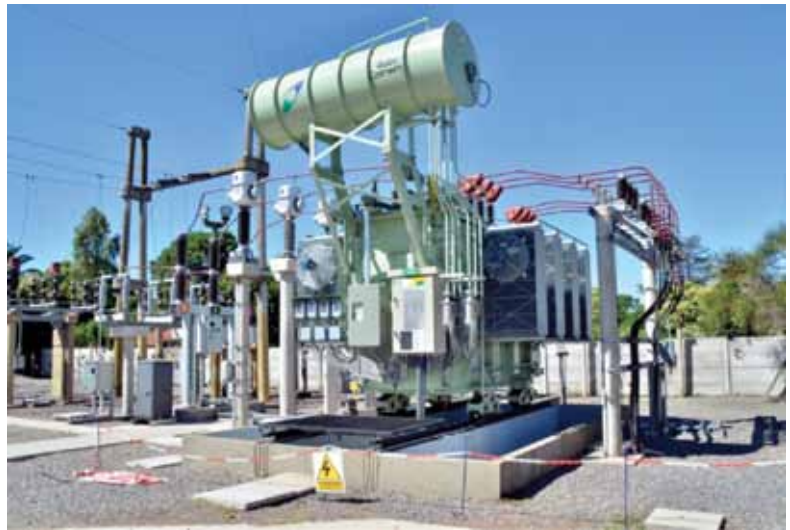
Obras de ampliación de la Estación Transformadora de Baradero.
