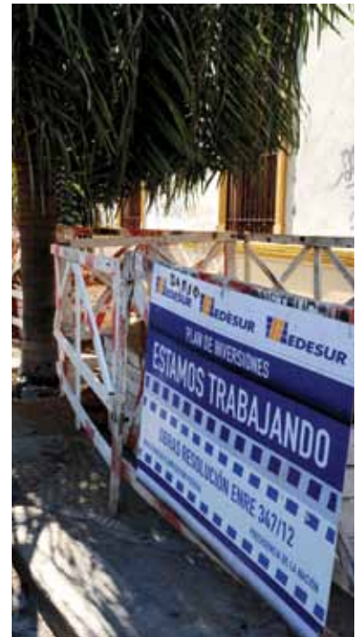
La zona de trabajo, señalizada.
