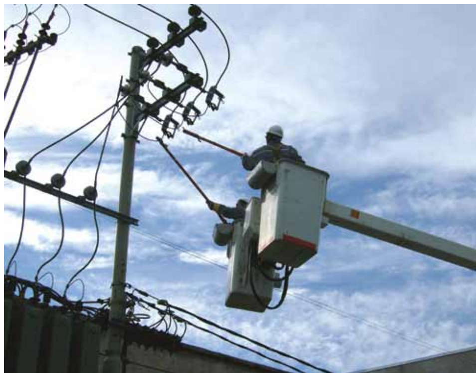
Una cuadrilla de trabajo con tensión en plena tarea.
