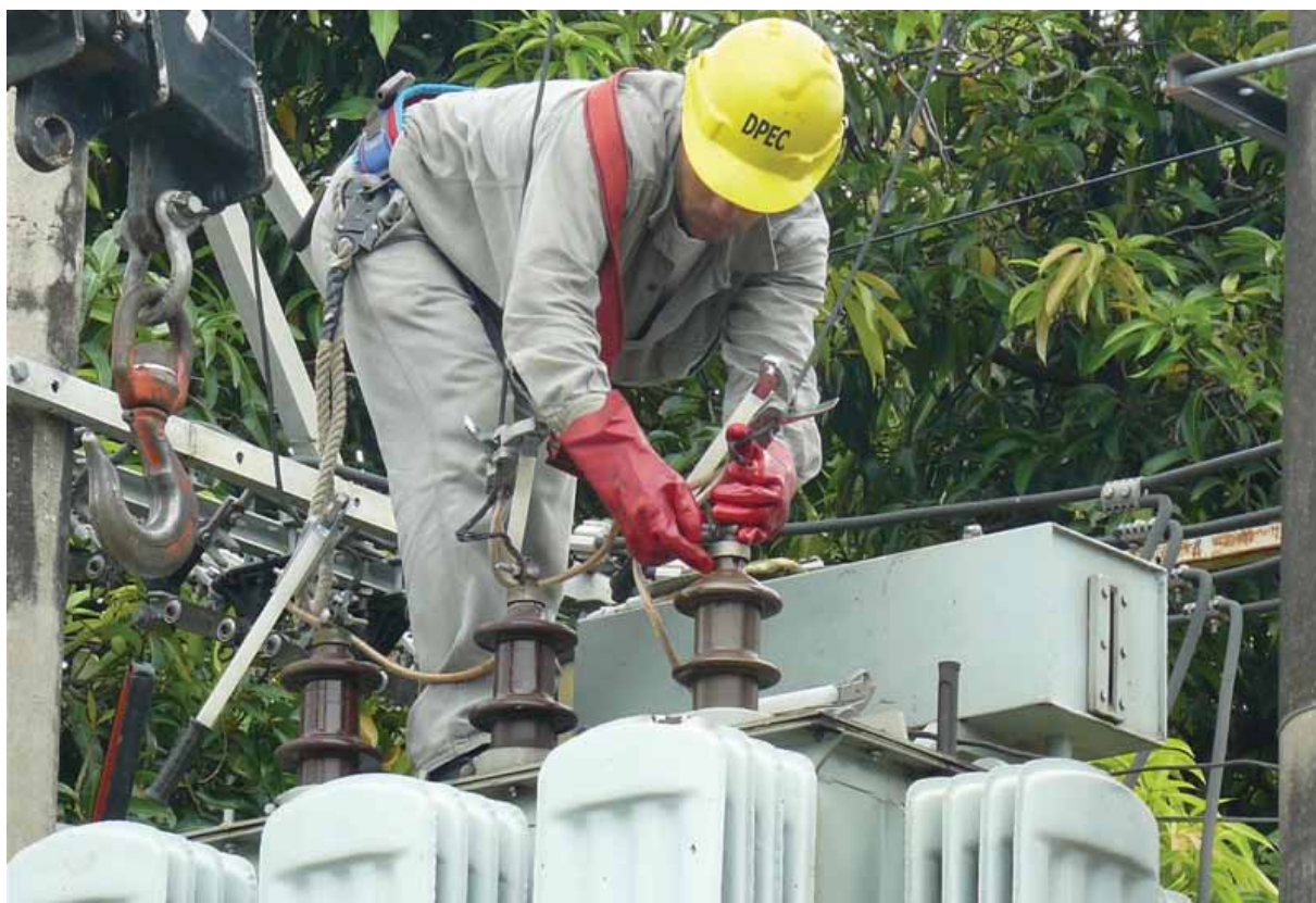
El esfuerzo de los operarios se reflejó en el correcto funcionamiento de las nuevas Subestaciones Transformadoras Aéreas.
