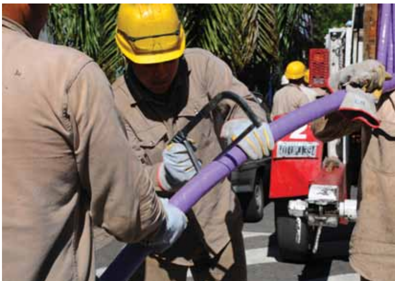
Operarios de EDESUR en plena tarea.
