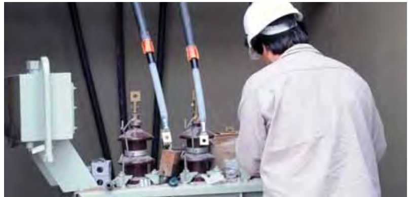
Operarios especializados efectuaron el montaje de las instalaciones.
