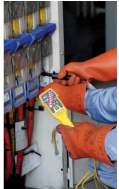
Se midió la corriente de los alimentadores para equilibrar la carga.
