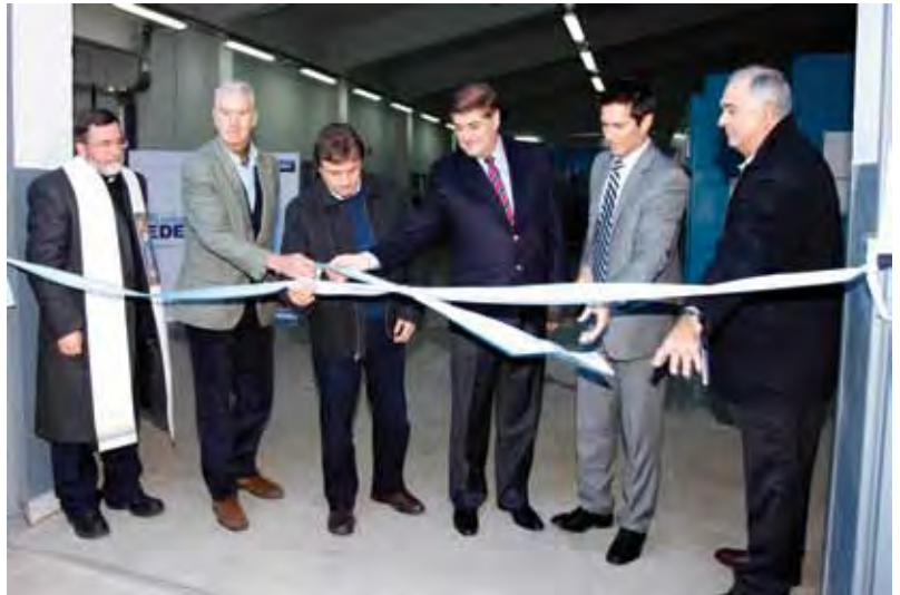
La ET inaugurada significará un aumento del 17% por ciento de la potencia instalada en Mar del Plata.
