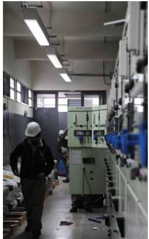
Operarios especializados se ocupan del montaje de los paneles en la subestación.
