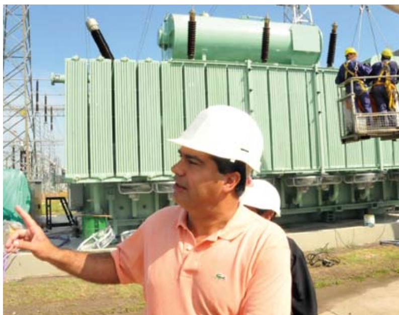
El Gobernador Jorge Milton Capitanich recorriendo la instalación del nuevo Transformador de 300 Mw en la ET 500 Kv Resistencia
