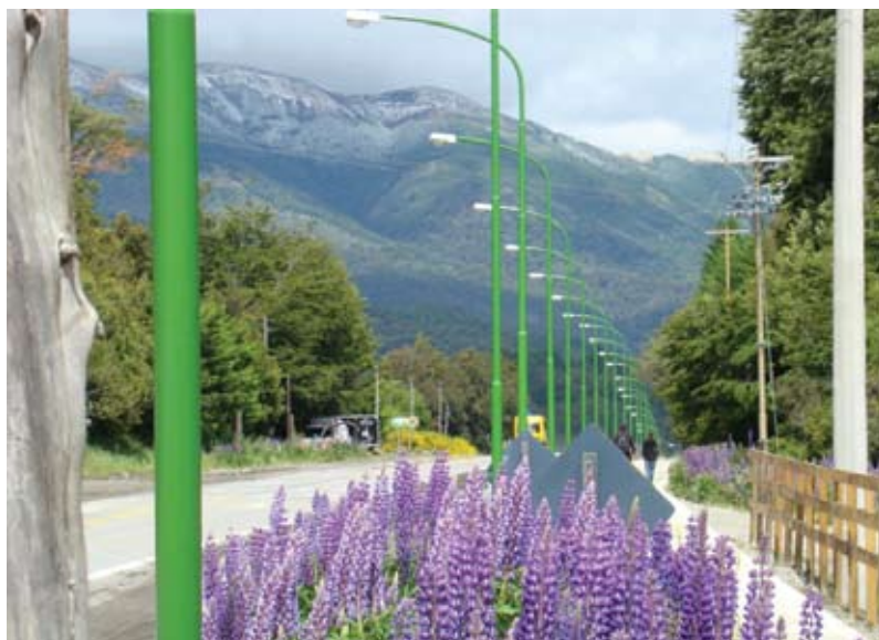
Una vista de las nuevas luminarias
