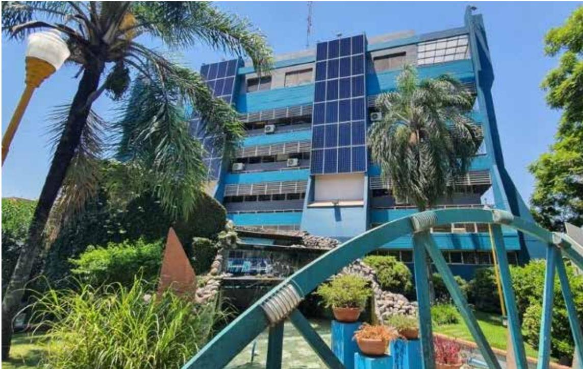
La empresa instaló 48 módulos fotovoltaicos, dispuestos en dos columnas, en la cara norte del edificio principal.
