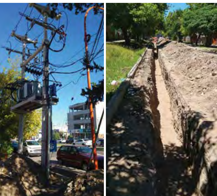
Trabajos de instalación del alimentador Iselín-Rawson. Obras para instalar el trazado bajo tierra.
