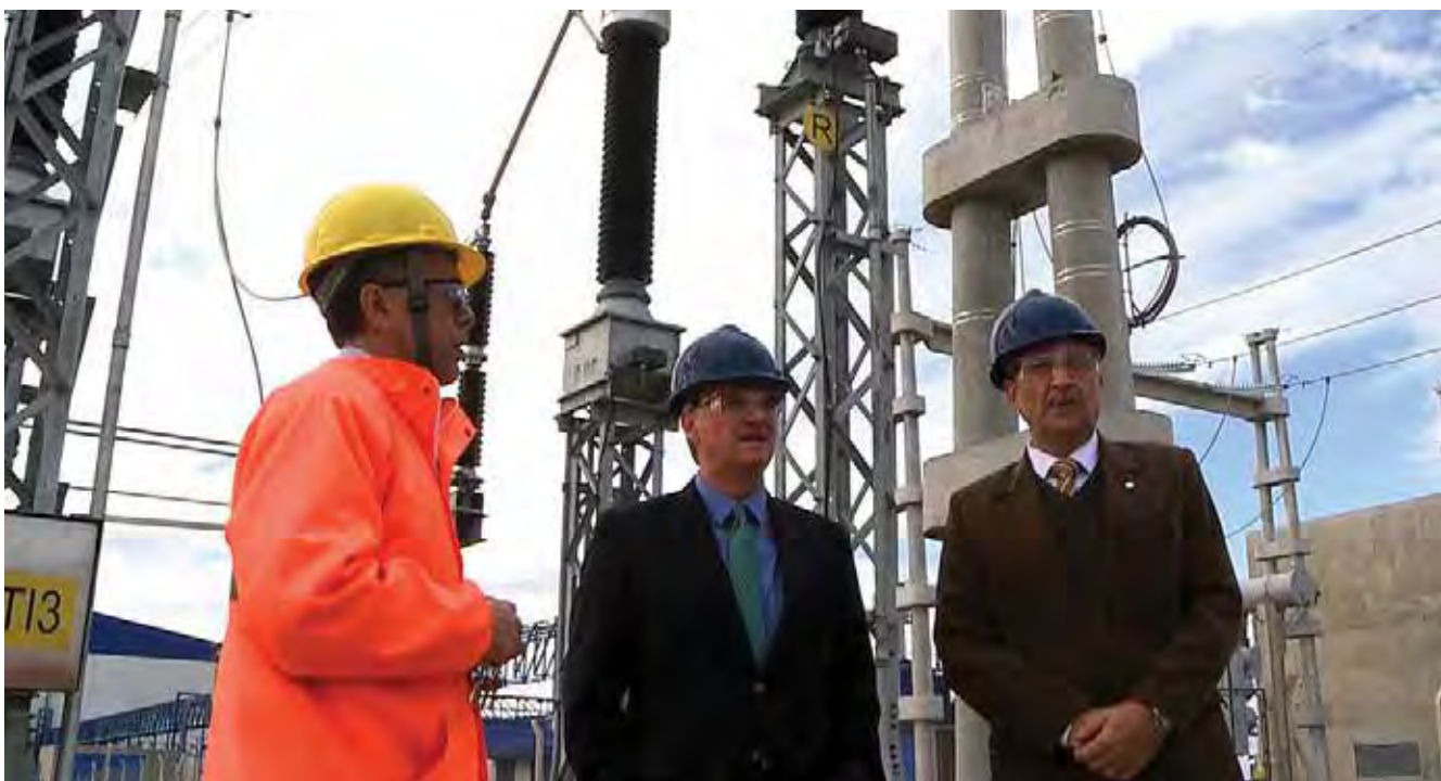
El Ing. Raúl Stival, presidente de la EPE y el Ing. Marcelo Cassin, Gerente General, en la Estación Transformadora Gerdau.
