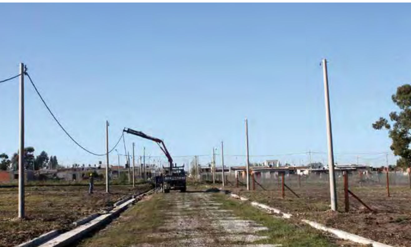
Trabajos de instalación de columnas para el alumbrado público.
