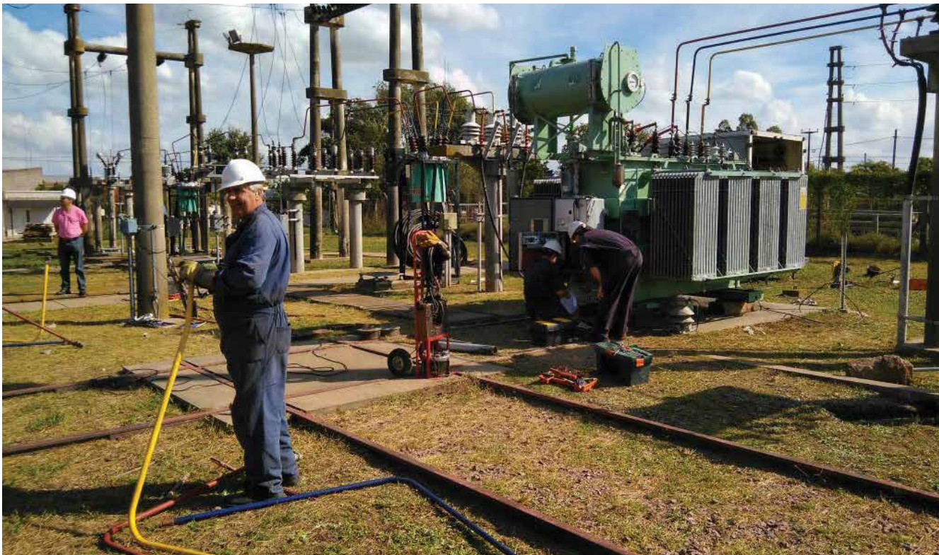
Operarios durante los trabajos para duplicar la potencia de la estación transformadora.
