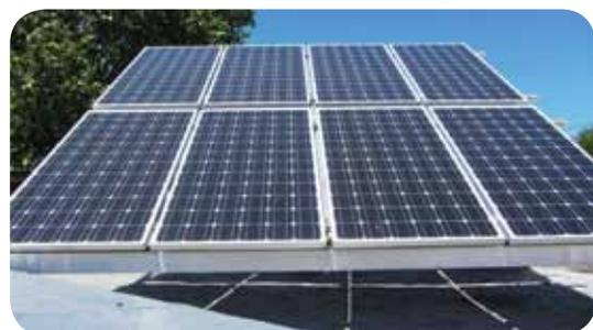
El nuevo sistema de generación fotovoltaica incluye 8 paneles solares de 185 W cada uno
